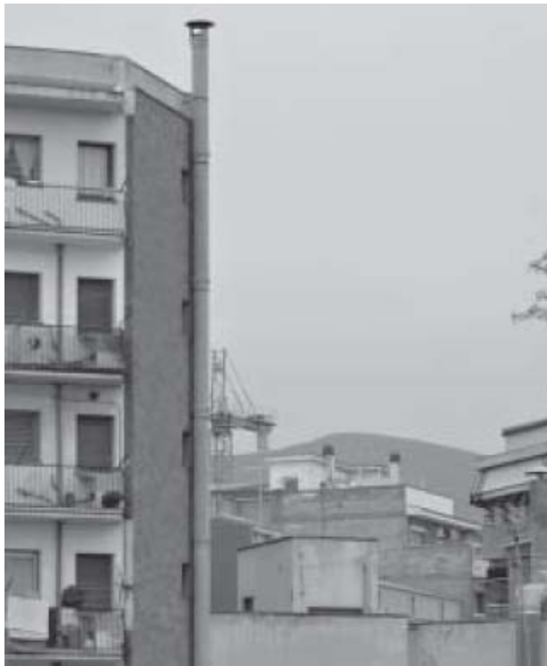
Figura 10 Conducto de aireación de fibrocemento
